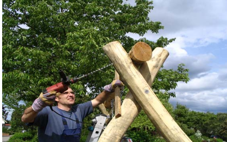
Bild 1, Abbildung zeigt Montagesituation an einem Gestell aus Robinie
